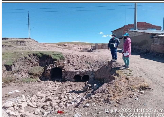
Fotografía 3: Alcantarillas que se obstruyen con las maximas avenidas de la quebrada Gashan.
