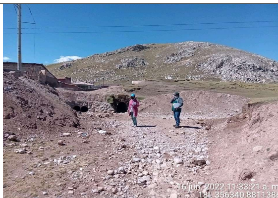
Fotografía 2: Alcantarillas que se obstruyen con las maximas avenidas de la quebrada Gashan.
